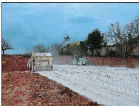
Terrassement pour Polygone rue du Dr Ségala : 41 logements
